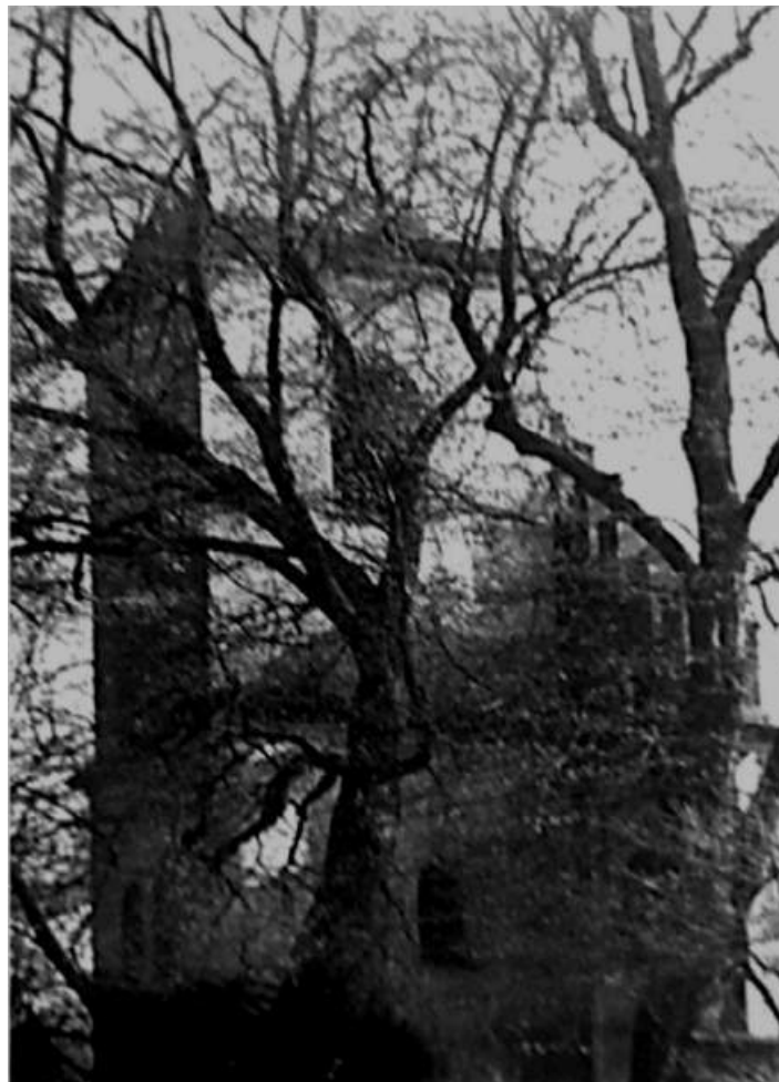
Wieża starego kościoła od strony południowo zachodniej - stan z około 1990 roku
