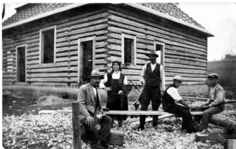
Budowa Domu Ludowego, 1932 (lub 1933)r. Od lewej: Franciszek Baran, sołtys i naczelnik straży pożarnej w Sieprawiu, prowadzący nadzór nad budową, kobieta NN, Jan Oramus, majster ciesielski, Joachim Oramus, Adam Oramus, syn Joachima.
