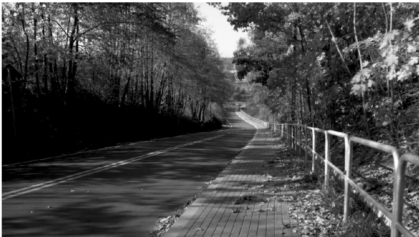
Zmodernizowana ul. Szkolna w Czechówce.
