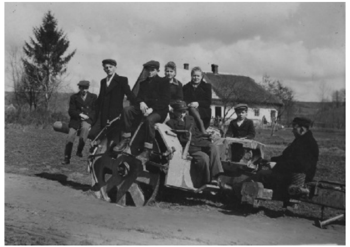
4. Przy drodze wiodącej w kierunku centrum Sieprawia, w okolicach Domu Ludowego (wczesną wiosną 1945 r.) Porzucone niemieckie działo, pozostałość walk z armią sowiecką w styczniu 1945 r. zostało ono później przecięnię w pobliżu Domu Ludowego (zob. zdjęcie nr 5), pojawił się pomysł, aby jego lufę przetopić na dzwon, ale pomysł ten zarzucono i ostatecznie została ona wraz z działem zakopana. Rozpoznane osoby: Władysław Surówka z przysiółka Granice (drugi od lewej), Janina Matoga z domu Janus i Irena Machaj z domu Matoga (kolejno czwarta i piąta od prawej).
