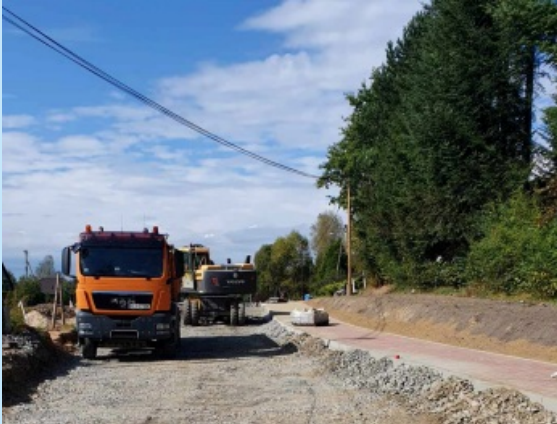
Przebudowane skrzyżowanie ul. Jana Pawła II z ul. Lipową str. 4
