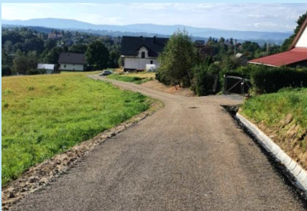
Wyremontowana droga rolnicza - ul. Sosnowa str. 4
