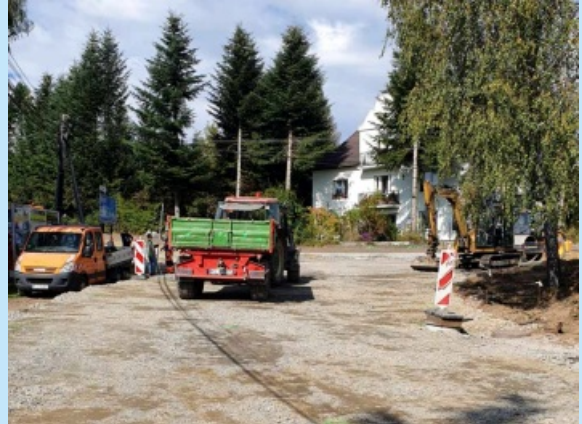
Przebudowane skrzyżowanie ul. Jana Pawła II z ul. Lipową str. 4
