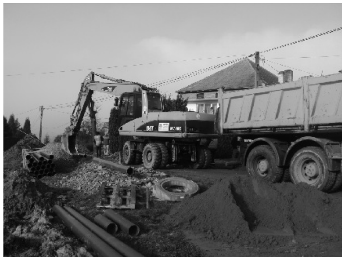
Budowa kanalizacji sanitarnej
