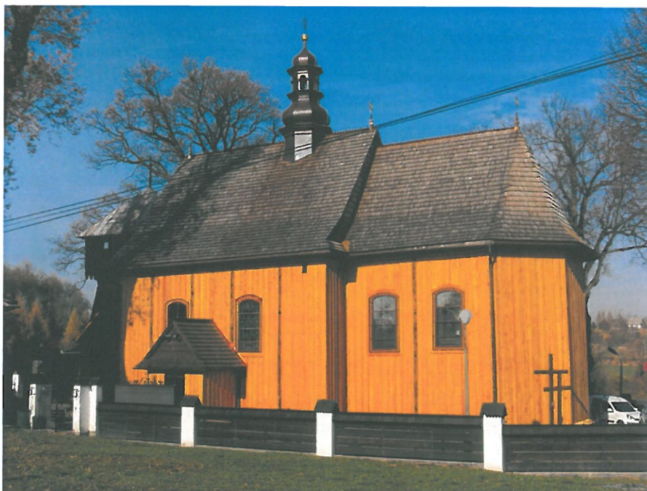
Zdj. Nr 5. Kościół parafialny p.w. Wszystkich Świętych w Zakliczynie wpisany do rejestru zabytków.
