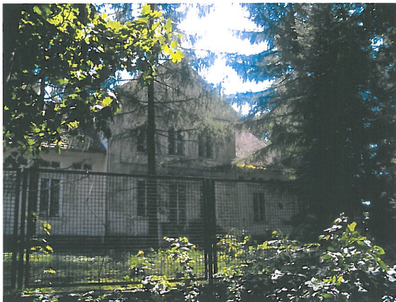
Zdj. nr 7. Budynek dworu w Zakliczynie.
